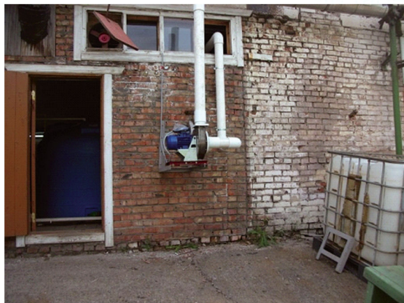
Вентиляционная система удаления водорода из электрохимических модулей
